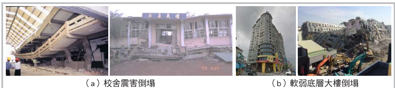
圖1：老舊RC建築震損之情況。
