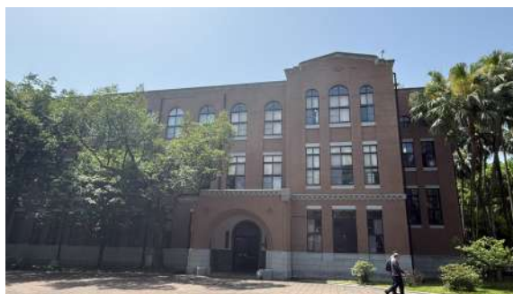
完成外牆修復的一號館
