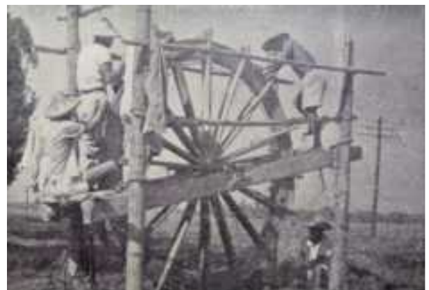
圖3：「竹井」施工照片。圖中右側坐姿者所在之處即為未來之井孔。鑿井原理為施工者以腳施力，踩踏木輪，帶動木輪上的竹片，竹片與鑽頭銜接，把金屬鑽頭從下往上拉，再利用重力往下砸。（資料來源：地下水工程處 1963）
