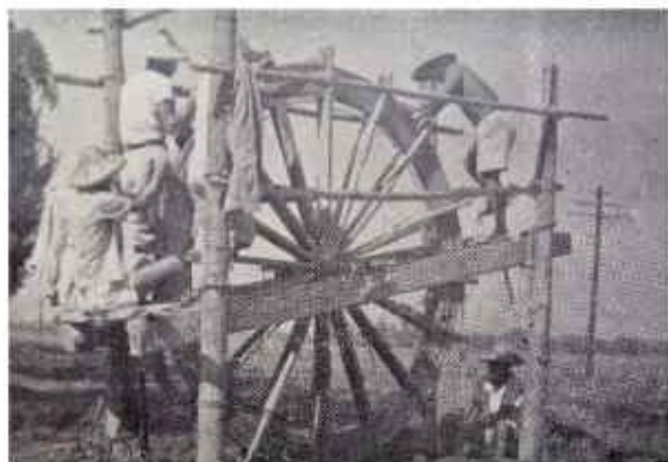
圖3：「竹井」施工照片。圖中右側坐姿者所在之處即為未來之井孔。鑿井原理為施工者以腳施力，踩踏木輪，帶動木輪上的竹片，竹片與鑽頭銜接，把金屬鑽頭從下往上拉，再利用重力往下砸。（資料來源：地下水工程處 1963）
