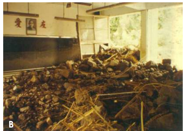
圖2：1996年賀伯颱風期間，極端降雨造成臺大實驗林和社營林區內的隆華國小校舍，受到土石流嚴重的破壞衝擊，（A）土石流涵蓋整個隆華國校校區；（B）土石流破壞了隆華國小教室。
