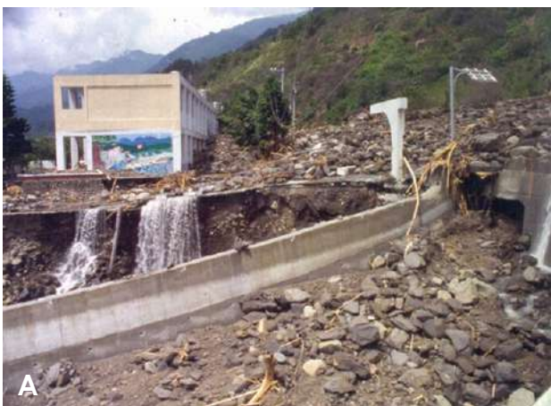
圖2：1996年賀伯颱風期間，極端降雨造成臺大實驗林和社營林區內的隆華國小校舍，受到土石流嚴重的破壞衝擊，（A）土石流涵蓋整個隆華國校校區；（B）土石流破壞了隆華國小教室。
