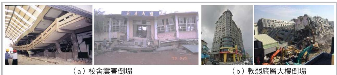
圖1：老舊RC建築震損之情況。
