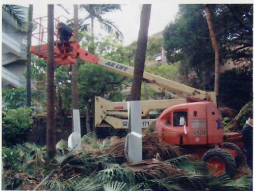
圖 11 事務組協助修剪過密的樹冠，而施工中所有樹幹包覆保護，減少損傷。
