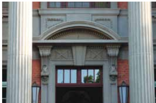
行政大樓正面入口施工精良的洗石子裝飾（柱頂石、卵形飾、月桂葉飾）。
