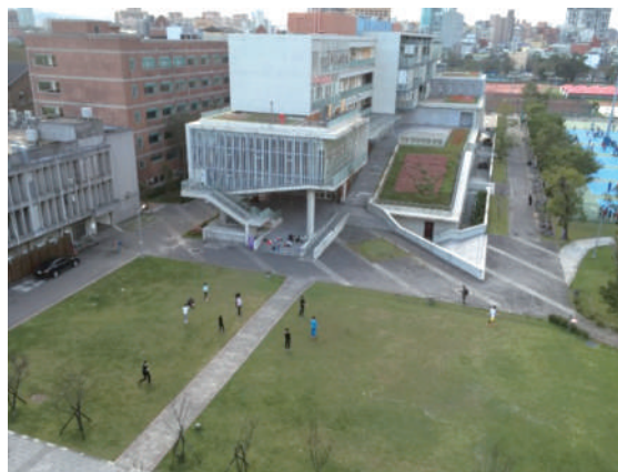
位於醉月湖南側的博雅教學館與戶外綠地，以透地雷達確認綠地下方的瑞公圳舊圳道仍存在。(地圖-C)
