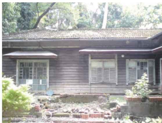
馬廷英故居為市定古蹟，整修前屋內漏水、部分地板沉陷、牆壁斑駁部份損毀，庭院雜草叢生。
