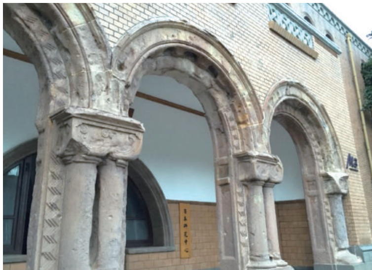
舊圖書館立面石柱因長期風化而缺損，於2015年塗覆復健劑及撥水劑以強化現有砂岩，並整體施作防護劑，阻絕外來水氣及紫外線。(地圖-D)
