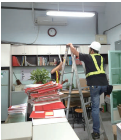
全校室內T8燈管更換為省能的T5燈管，每年至少節電431萬度。
