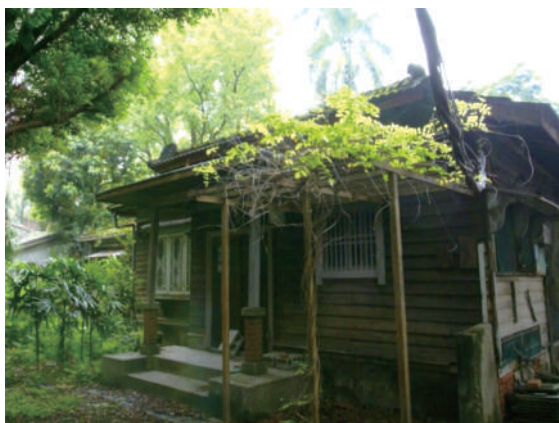
馬廷英故居為市定古蹟，整修前屋內漏水、部分地板沉陷、牆壁斑駁部份損毀，庭院雜草叢生。
