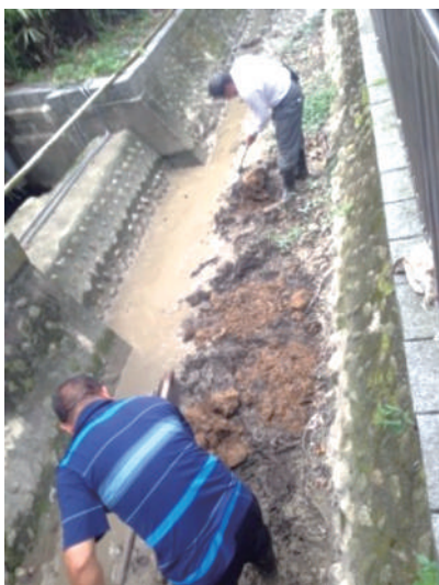
舟山路水工所旁的舊圳道，2015年10月以黏土整修，減少滲水程度。(地圖-B)
