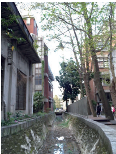
舟山路水工所旁的舊圳道不再乾涸，近期將再改造周邊環境、營造水圳景觀。(地圖-B)
