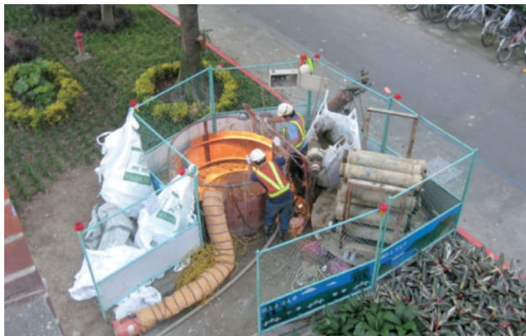
2008年起耗費3年，完成校總區污廢水下水道佈設工程。
