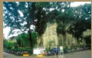
圖9：這兩棟洞洞館已經判定即將要拆除。
