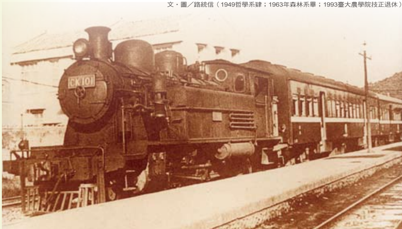
停靠在水源地車站的新店線列車。後方小樓房是鐵路職工宿舍。位於羅斯福路3段284巷口與汀州路3段155號南側。現存遺跡廢置許久，古樹濃蔭，荒煙蔓草。（攝影／洪祖仁）
