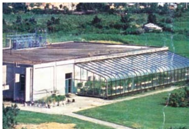
臺灣大學生農學院人工氣候室（第一代），於1969年6月落成。前排係自然光照精密溫度控制玻璃室，後面房屋有人工照明室、低溫暗房及大型冷媒壓縮機，供調控溫度條件，以進行植物對溫度反應之試驗研究。（圖片取材自《人工氣候室紀要》，1975-76）。
