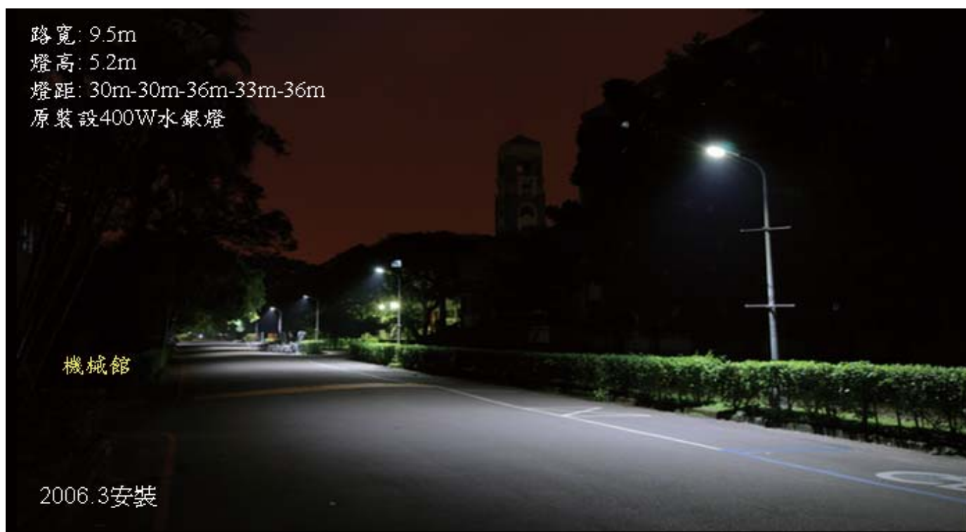
圖4：機械系新能源中心完成之臺大LED 示範道路（含 100W 太陽能LED）。
