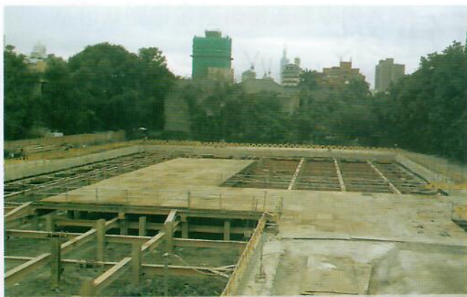
92年12月9日工地現況。已完成地下一層開挖及支架設置。
