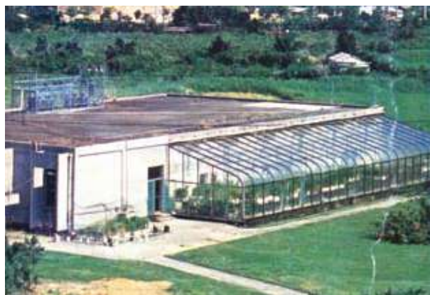
臺灣大學生農學院人工氣候室（第一代），於1969年6月落成。前排係自然光照精密溫度控制玻璃室，後面房屋有人工照明室、低溫暗房及大型冷媒壓縮機，供調控溫度條件，以進行植物對溫度反應之試驗研究。（圖片取材自《人工氣候室紀要》，1975-76）。
