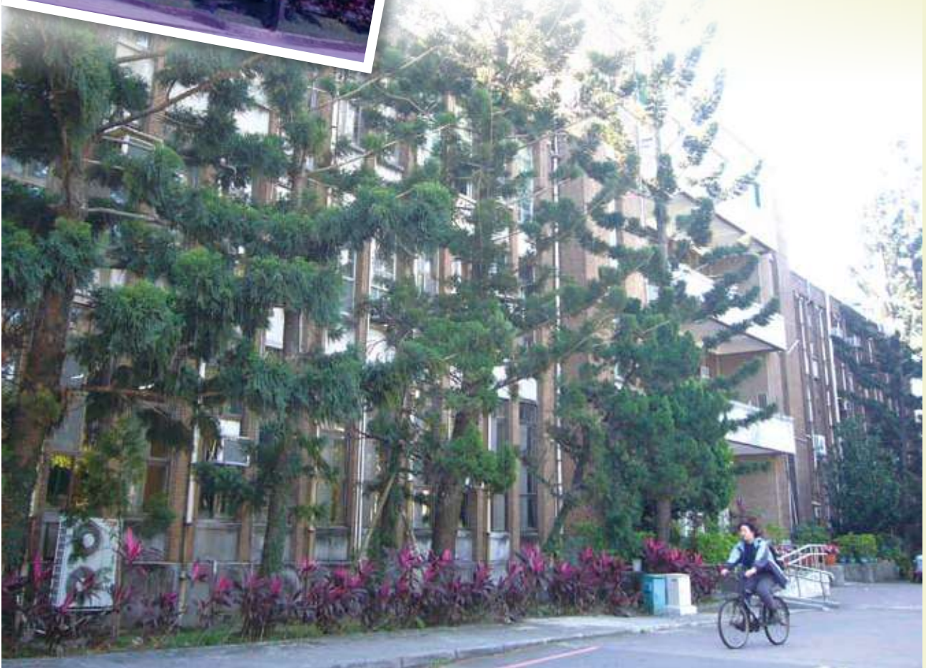
在校園一棟棟新建高樓對比下，森林館顯得老舊許多，館外的南洋杉樹群，則是風華正盛（2009）。
