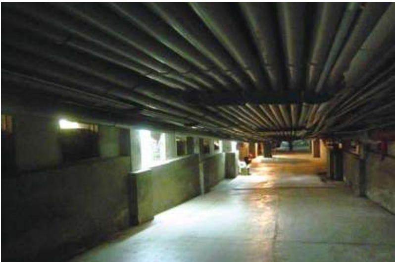
地下通道上面有許多橫樑、管線，行走時必須彎著腰。
