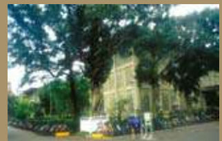
圖9：這兩棟洞洞館已經判定即將要拆除。
