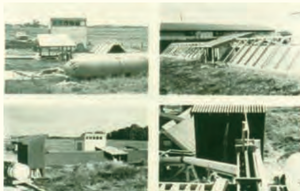
圖2：1981-1984年建造的高溫沼氣槽，經3年實驗，證實高溫沼氣可行。
