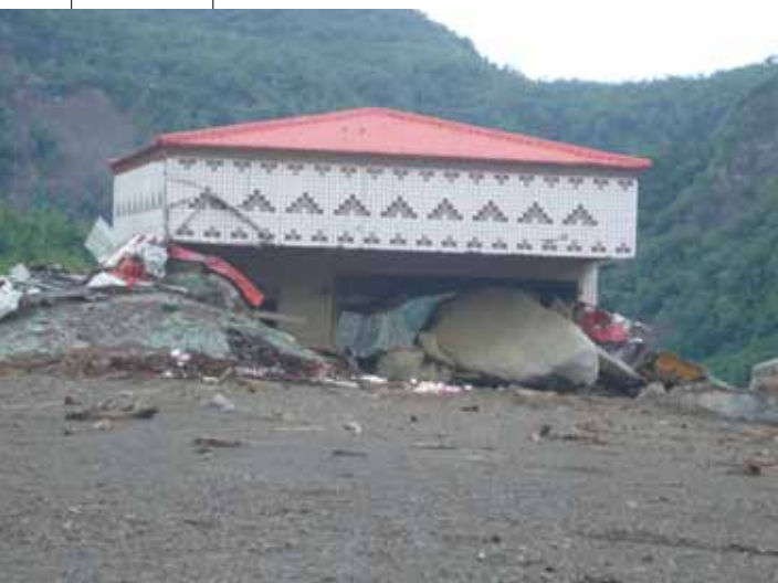
被土石流沖毀的民宅。
