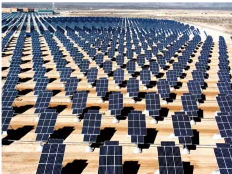
太陽能發電廠。 http://upload.wikimedia.org/wikipedia/commons/4/45/Giant_photovoltaic_array.jpg
