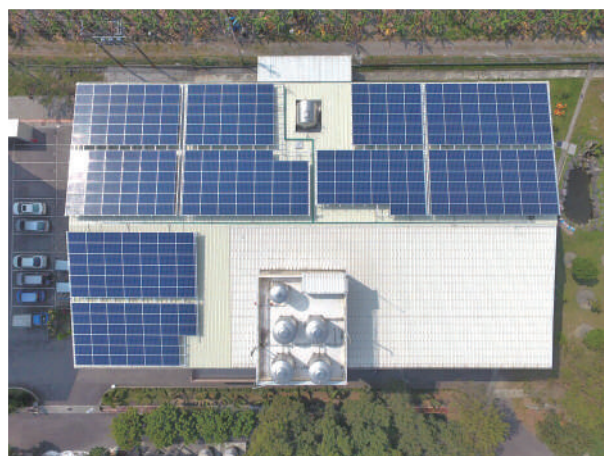
「大同之家」架設完成之太陽能板。
