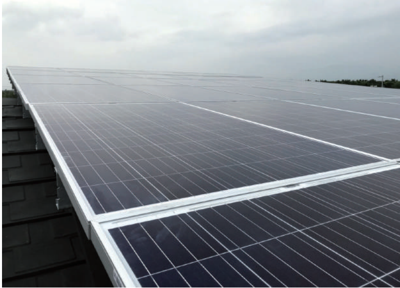
自家陽台就能發電，陽光伏特家讓小眾也能投資電廠，圖為海角一二號施工現場。
