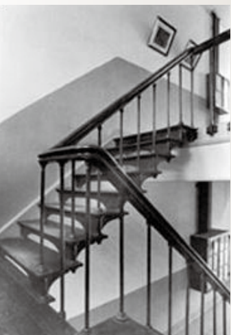
舊藥學館中央樓梯。
