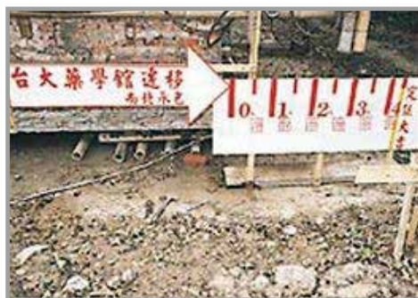
舊藥學館遷移工程，是臺北市首例建築體整體遷移定位工程，採用up-down工法，向北移動了22.57公尺。
