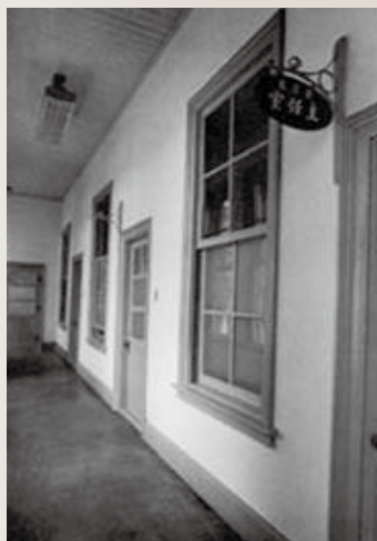
舊藥學館二樓走廊
