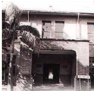
舊藥學館一景。藥理學科移撥給藥學系使用時增建部分房屋。
