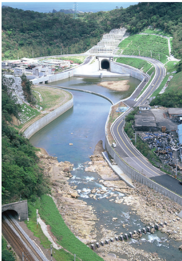
圖 4：基隆河瑞芳附近採用員山子分洪入口處（經濟部水利署第十河川局提供）
