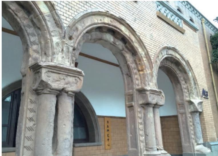
舊圖書館立面石柱因長期風化而缺損，於2015年塗覆復健劑及潑水劑以強化現有砂岩，並整體施作防護劑，阻絕外來水氣及紫外線。(地圖-D)
