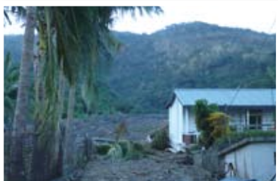
大鳥村民宅被土石流沖毀，右上方白色房屋原為2層樓，一樓已被淹沒。
