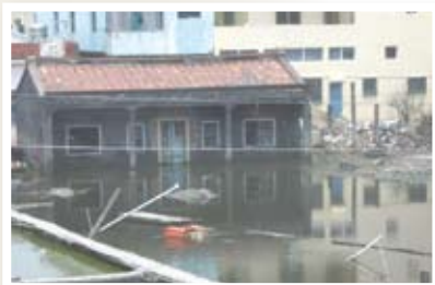
佳冬鄉塹豐村為一級重災區，淤積深及胸口，仍需國軍重型機具清淤開路。
