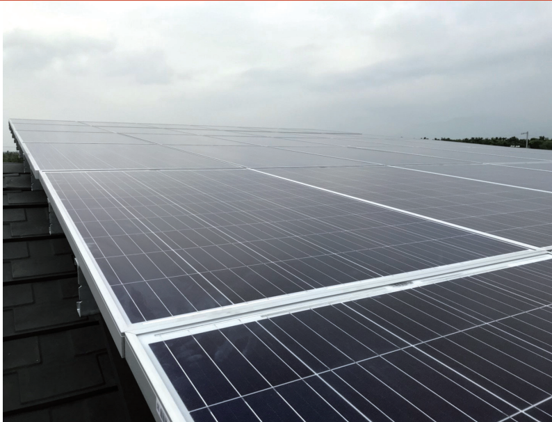
自家陽台就能發電，陽光伏特家讓小眾也能投資電廠，圖為海角一二號施工現場。
