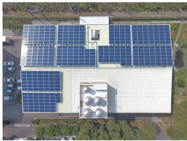
「大同之家」架設完成之太陽能板。
