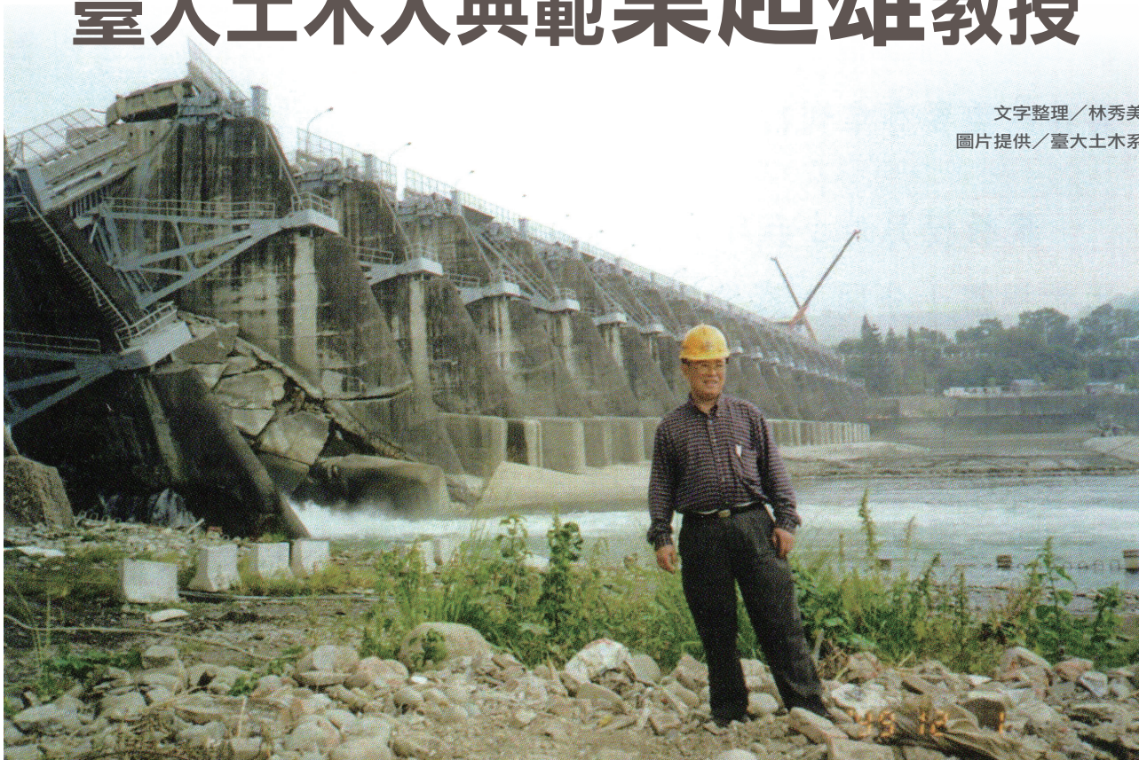
921大地震時進入災區勘災，於石岡壩。
