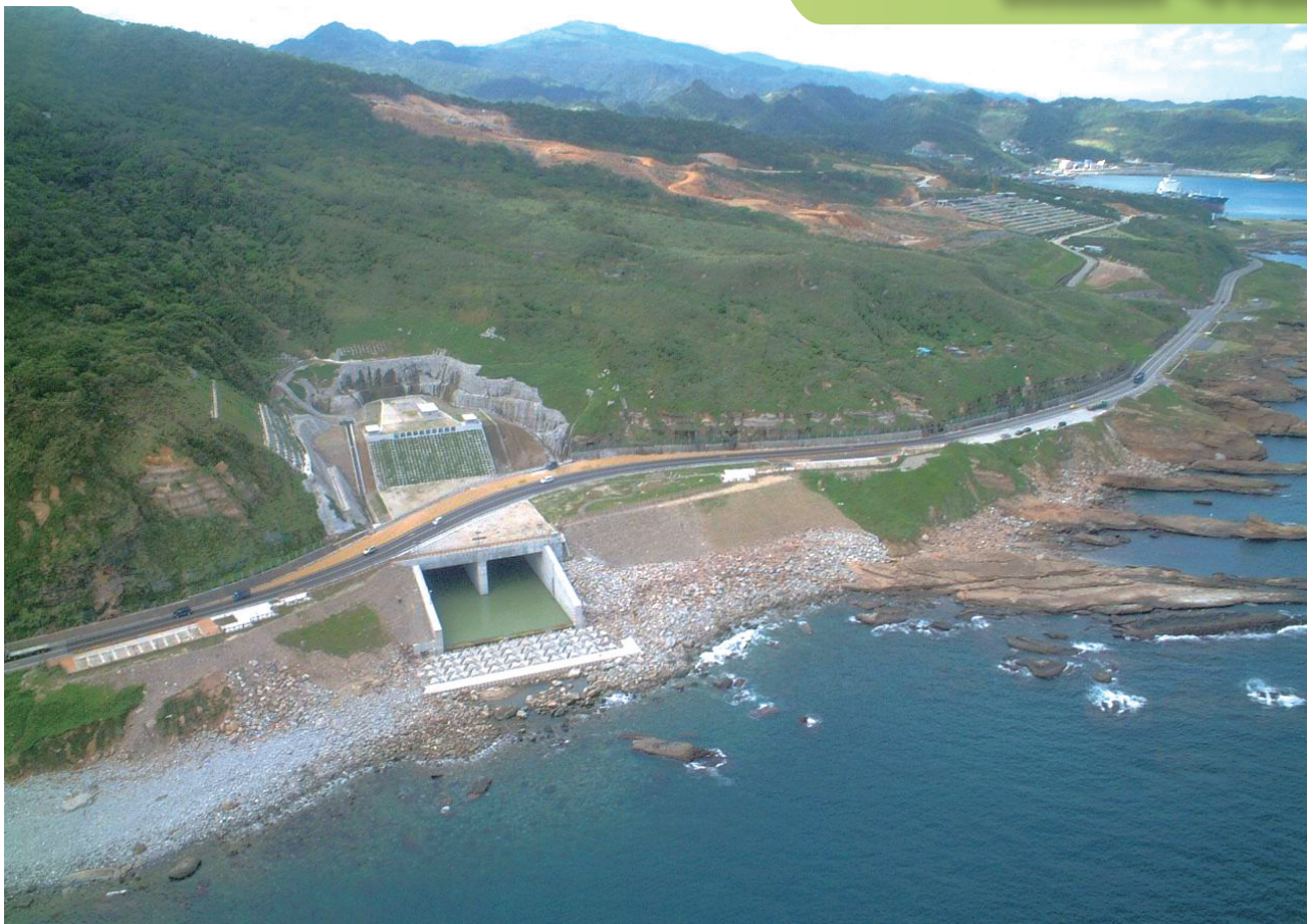
圖 5：員山子分洪出水口，臺二線濱海公路。（經濟部水利署第十河川局提供）
