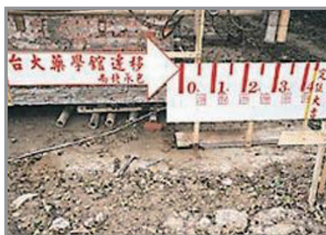
舊藥學館遷移工程，是臺北市首例建築整體遷移定位工程，採用up-down工法，向北移動了22.57公尺。
