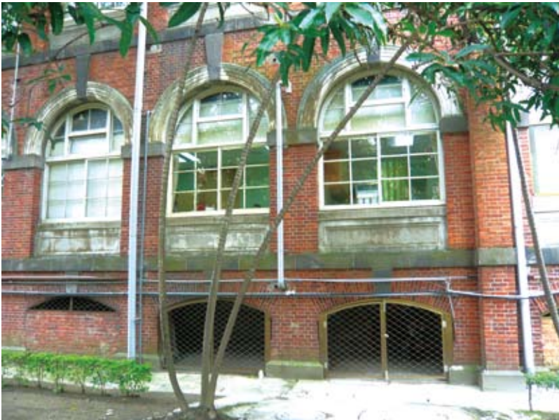
臺大醫院的地板下還有約一個人高的空間，這些空間都以半圓形的拱牆與庭院分隔，形成了臺大醫院縱橫交織的地下通道。
