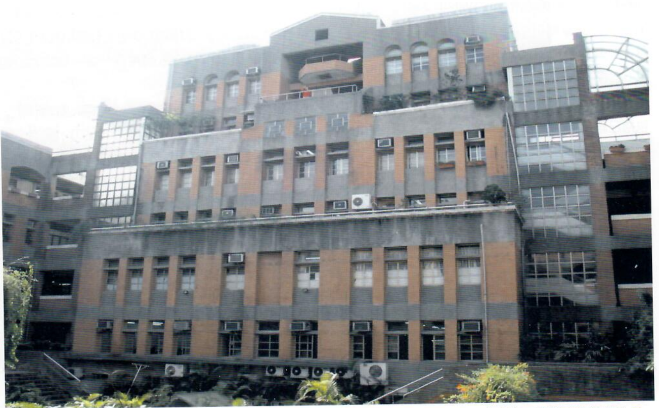
▲ 工綜一期外圍五層內圍七層。
