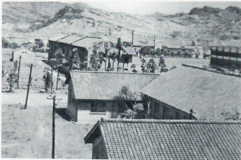
↑ 機械系周圍的老建築。
